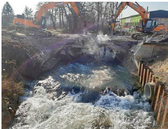
Der Abriss der alten Bierweg-Brücke
